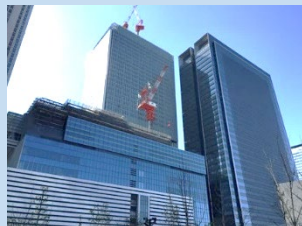
マンション・オフィスビル など
