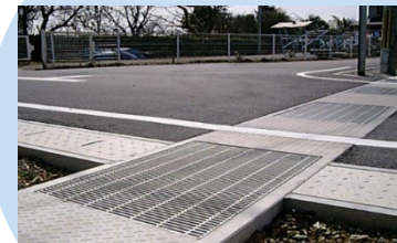
グレーチング(溝蓋)
